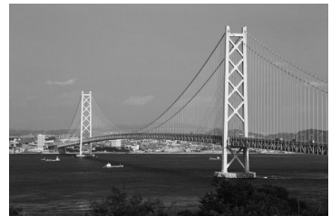
明石海峡大橋
